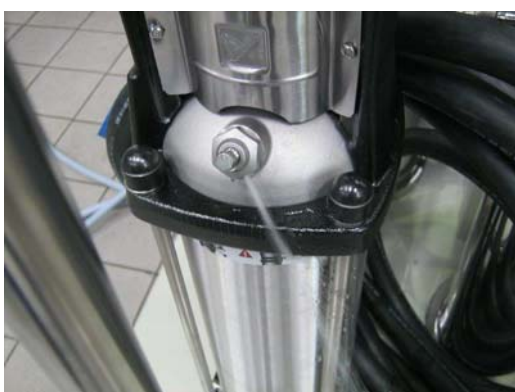
Figura 4-2: Se reglează debitul constant de apă
