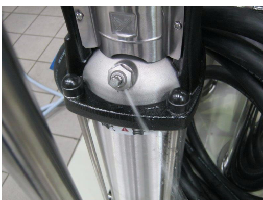
Attēls 4-2: Ieregulējas konstanta ūdens plūsma
