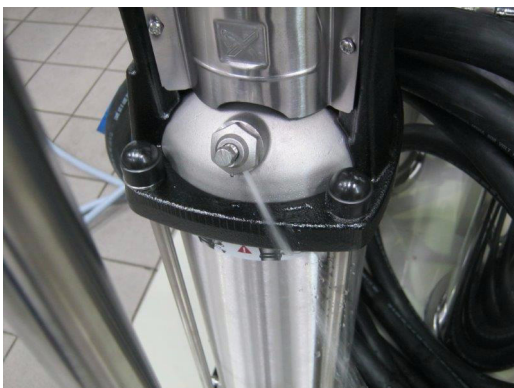
Ilustración 4-2: Se ajusta el flujo de agua constante
