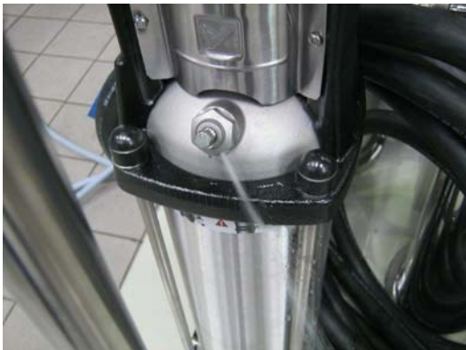
Abbildung 4-2: Konstanter Wasserfluss stellt sich ein
