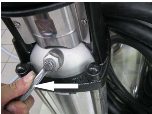
Obrázek 4-3: Zavřít odvzdušňovací šroub
